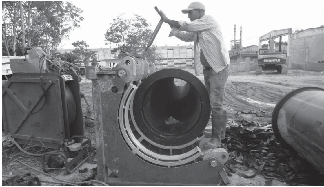
Unión de los tramos de tubería de Polietileno de Alta Densidad con la moderna tecnología italiana de soldadura por termofusión.
