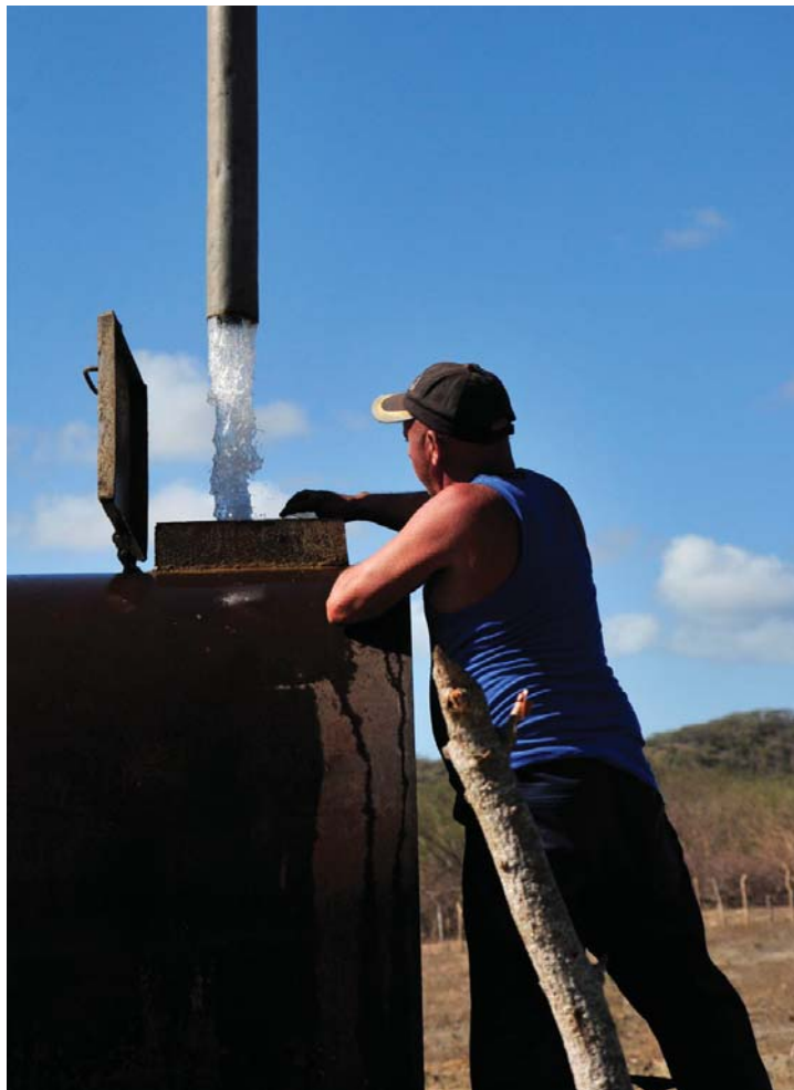
El nuevo cargadero de agua de La Güira es una de las obras concluidas.
