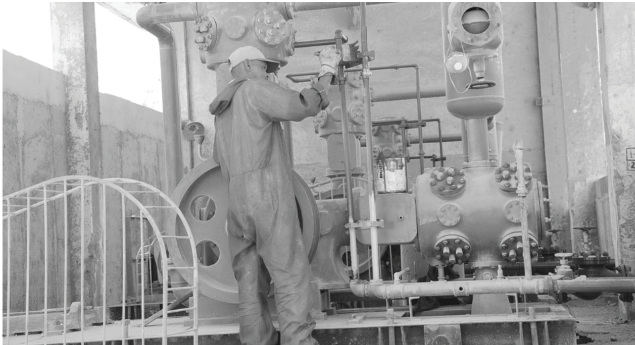
Un equipo de la Empresa de Servicios René Ramos Latour, de Nicaro, instala nuevos compresores de aire para homogeneizar la pasta. Foto: Vicente Brito
