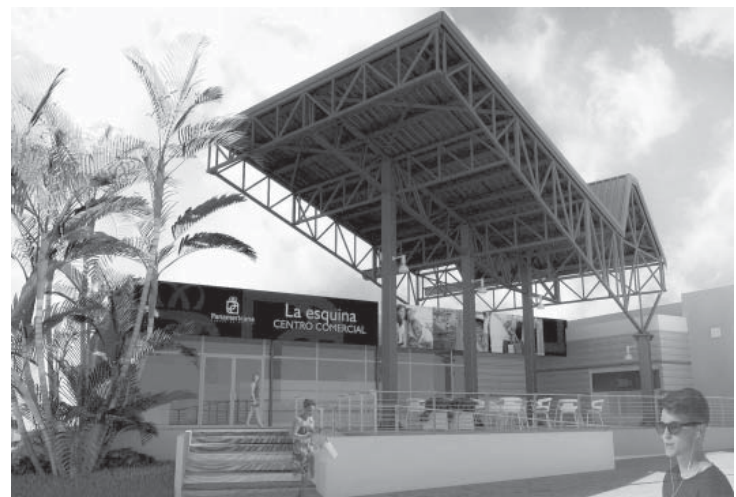
Imagen del proyecto, previsto en la confluencia de la Carretera Central y la Avenida de los Mártires.
