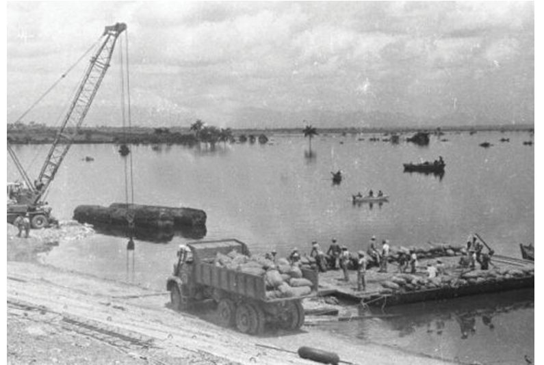
La balsa y un camión cargado de sacos terreros durante la lucha por salvar la presa. / Foto: GARAL
