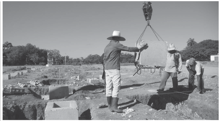
Actualmente se trabaja en las fases de movimiento de tierra y cimentación.
