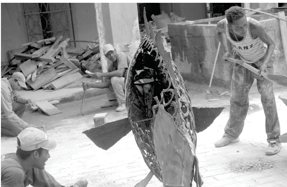
Los trabajos constructivos devolverán prestancia a la institución. /Foto: Reidel Gallo
