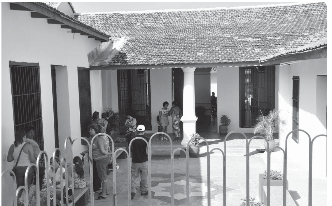
Entre las principales obras de la villa trinitaria sobresale la reconstrucción de la escuela primaria Pepito Tey.
