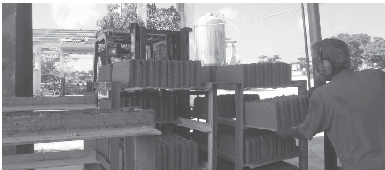
La Industria de Materiales de la Construcción, perteneciente al Micons, recupera su producción de bloques.
