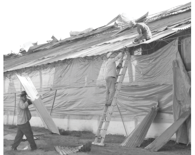
Largas jornadas de trabajo despliegan los techadores en la unidad Reemplazo, de Jatibonico. /Foto: Vicente Brito
