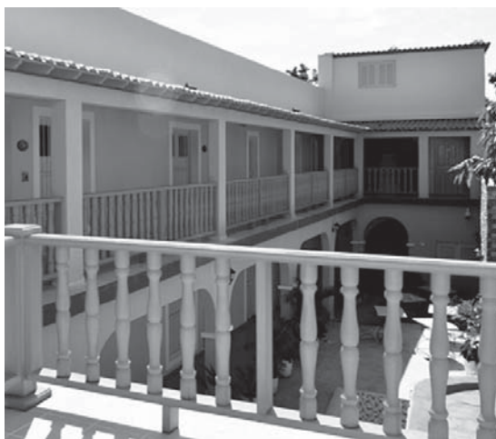
La instalación posee 12 habitaciones.
