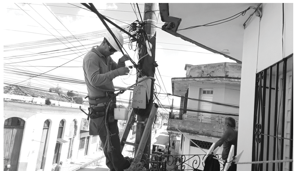
Los operarios han sustituido cables de 600 pares en dos días. /Foto: Lauris Henríquez
