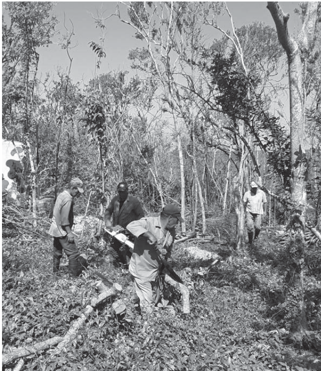
Los trabajadores del Parque Nacional Caguanes se han volcado a las labores de recuperación. /Foto: Lauris Henríquez
