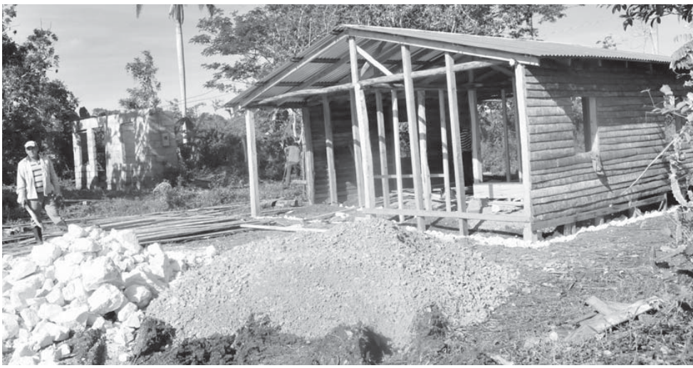
Nuevas casas se construyen para las familias afectadas. /Foto: Vicente Brito
