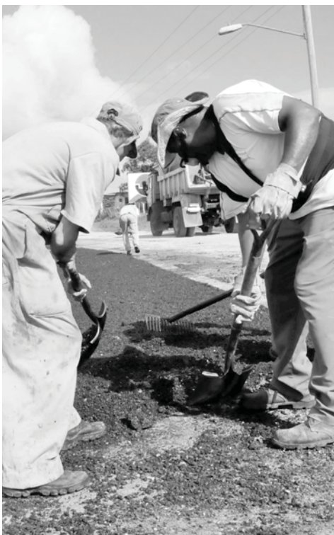
Fuerzas de la UEB Pavimentación se encargan de las labores de bacheo en el tramo Autopista-El Majá. /Foto: Vicente Brito
