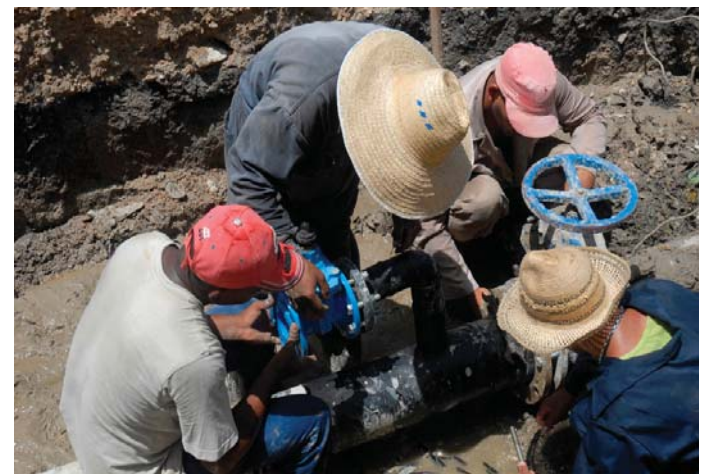
La reparación de tramos de tuberías averiadas constituye una prioridad en el territorio. /Foto: Reidel Gallo
