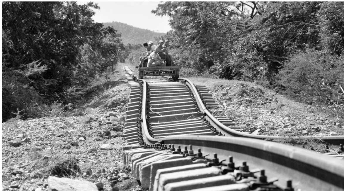
Así quedó la vía en uno de los tramos entre Manaca Iznaga y Condado luego de las lluvias asociadas al huracán. Fotos: Vicente Brito
