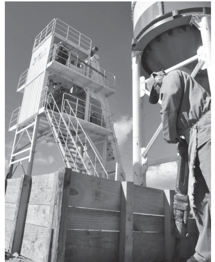
Se trabaja intensamente para concluir el montaje antes de que finalice enero. /Fotos: Vicente Brito
