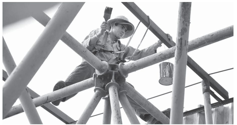
Los trabajos en la instalación resultan complejos. /Foto: Vicente Brito
