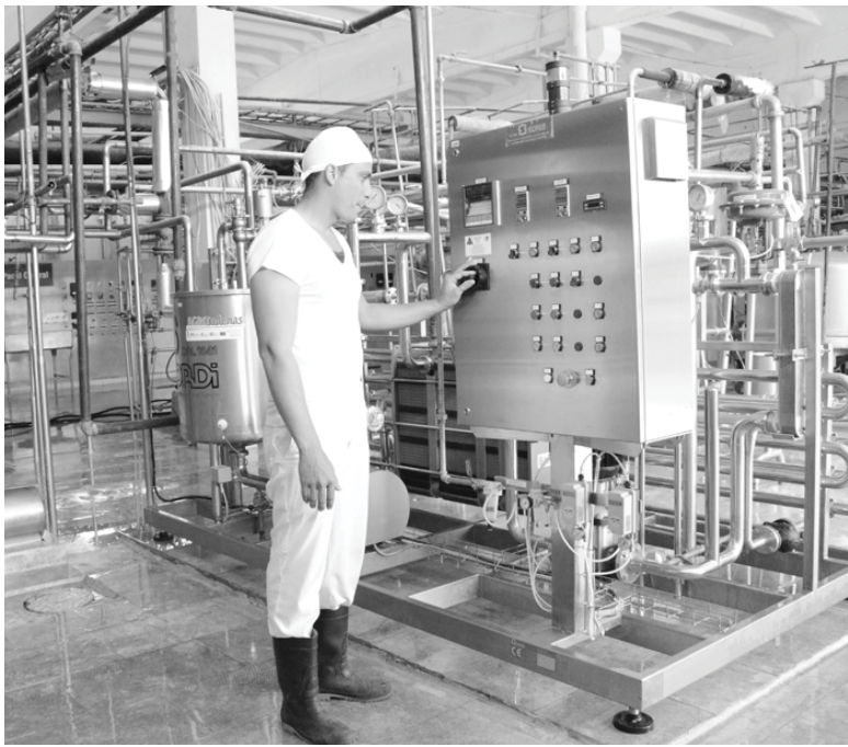
El montaje de un nuevo pasteurizador mejorará el proceso de producción de leche. Fotos: Vicente Brito
