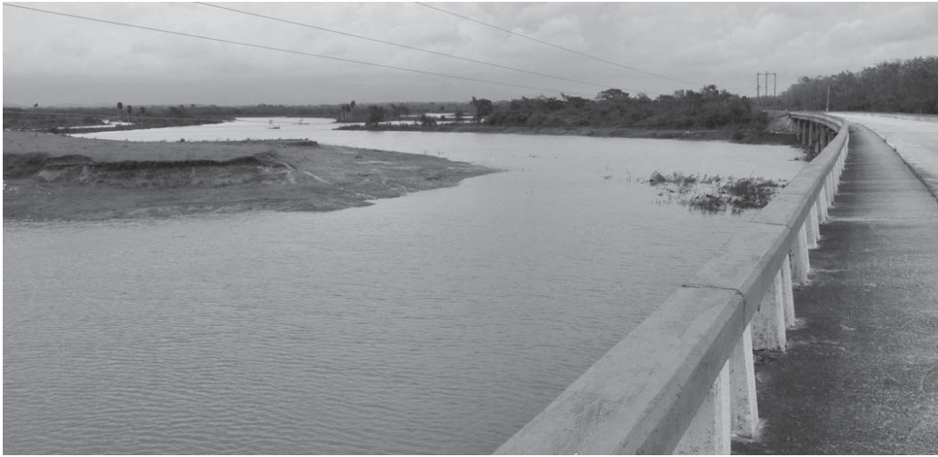
A las puertas de la primavera, la presa Zaza se mantiene con algo más de 810 millones de metros cúbicos de agua. /Foto: Vicente Brito
