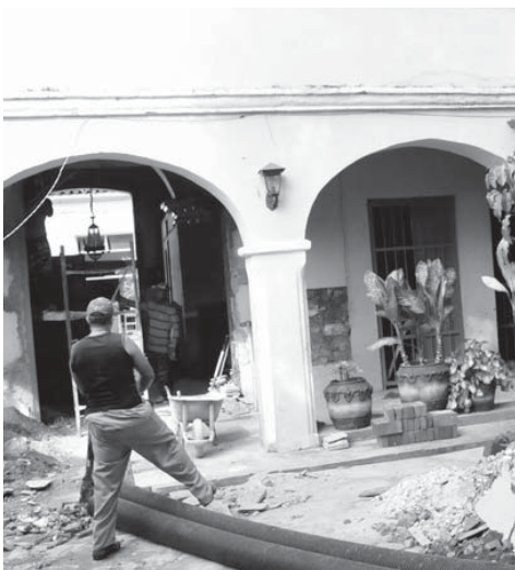
Trabajadores por cuenta propia reparan la edificación colonial./Foto: Vicente Brito
