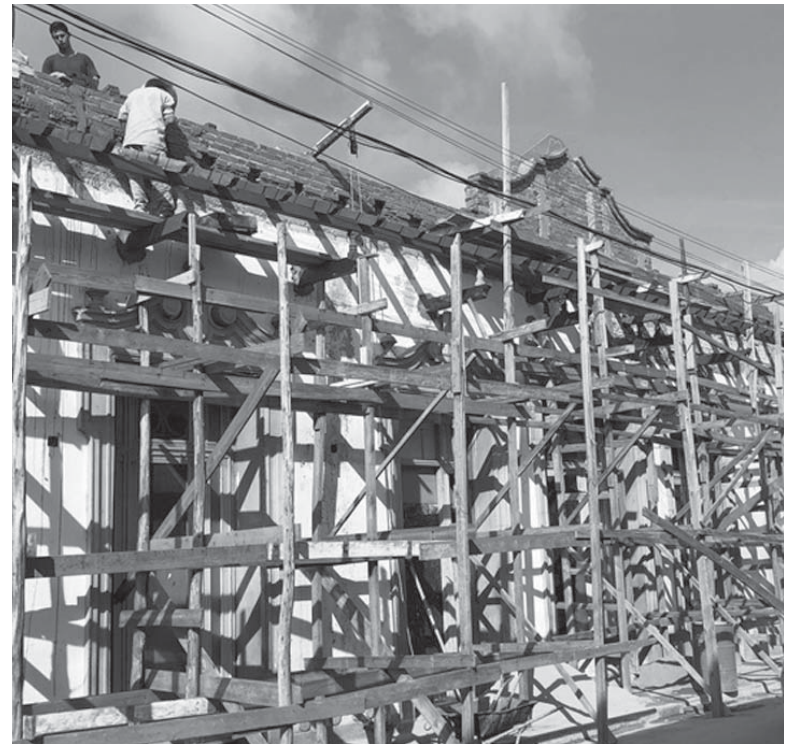
La constancia en las labores constructivas ha permitido el avance en la obra civil.
