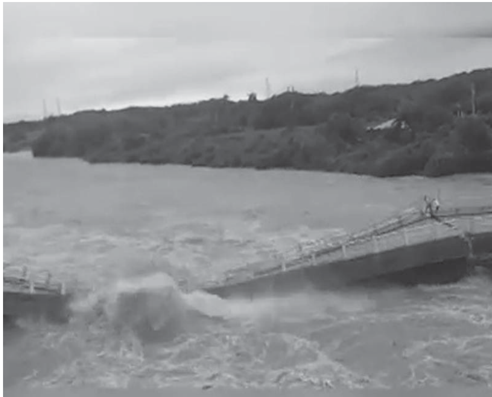
Momento en que colapsa el puente de Zaza del Medio, tomado por José Andrés Mena.
