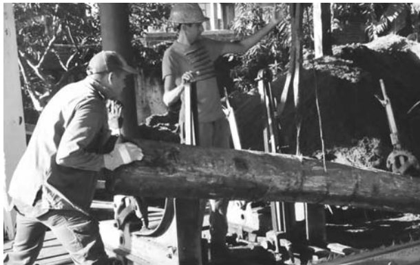
Buena parte de la madera acopiada tras el azote del ciclón se empleó en la recuperación de viviendas. /Foto: Vicente Brito
