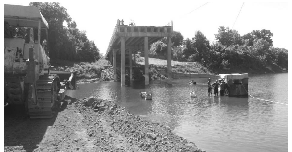
Constructores espirituanos avanzan en la ejecución del terraplén sobre el río.
