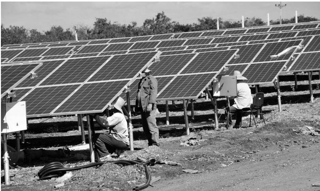
La generación del parque evitará la emisión de 5 603 toneladas de dióxido de carbono a la atmósfera. Foto: Vicente Brito
