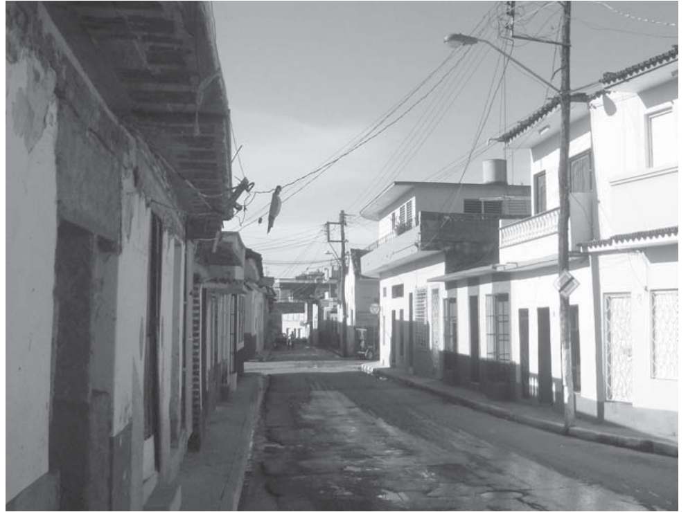
En la ciudad espirituanas las principales violaciones urbanísticas se encuentran en las cubiertas.
