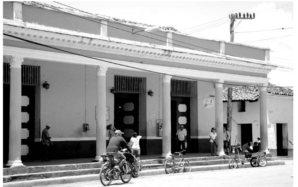
El 20 de julio los servicios comerciales fueron paralizados en El Convenio por las deficientes condiciones higiénico-sanitarias de la unidad. /Foto: Vicente Brito
