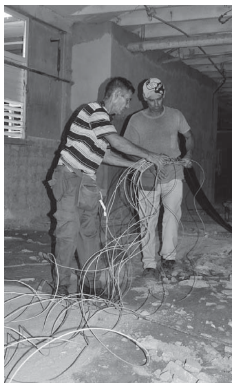
En la cocina-comedor se comienza el montaje de las redes eléctricas.
