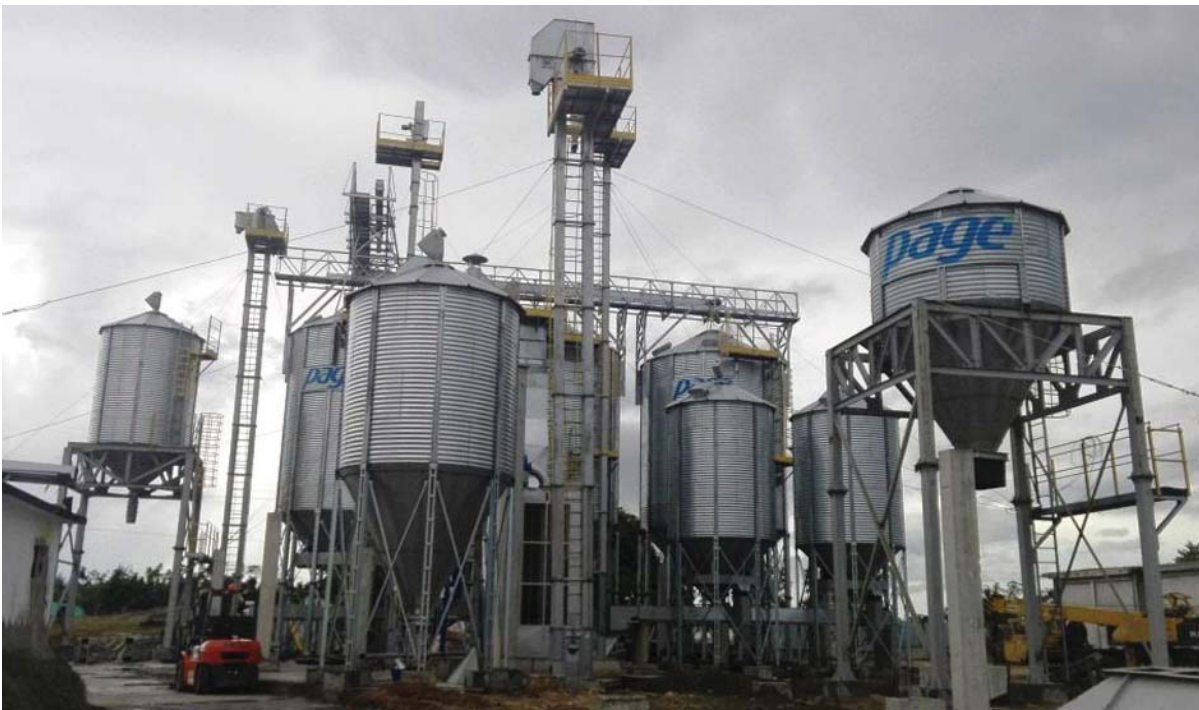
La obra, valorada en unos 4 millones de pesos, tiene ejecutado alrededor del 85 por ciento de su cronograma constructivo.
