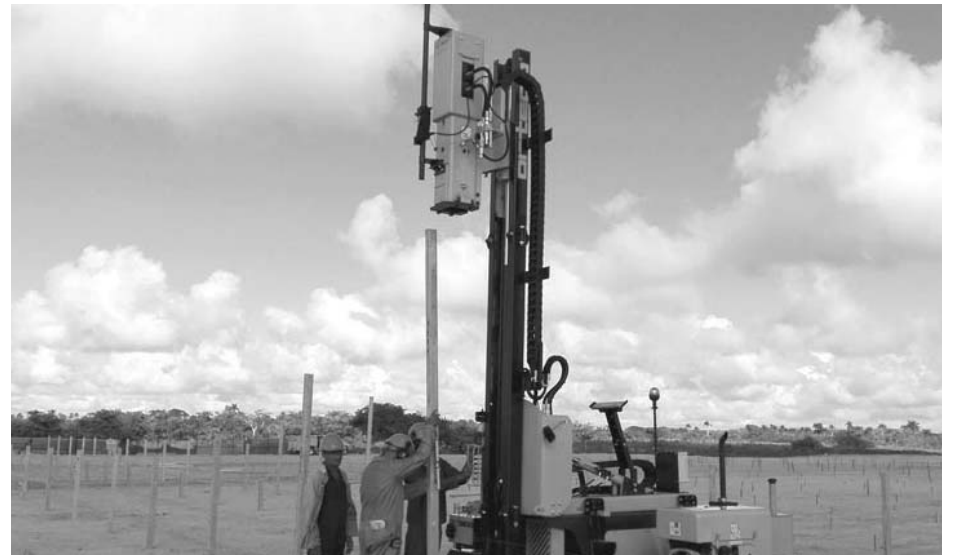
Esta máquina posibilita mayor precisión en la ubicación de los pilotes. /Foto: Alain Jiménez
