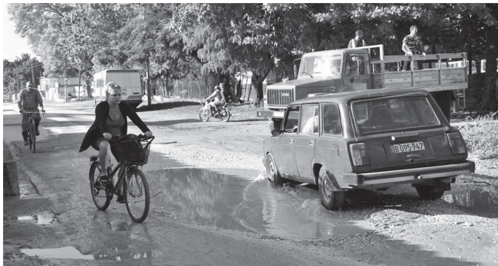
A causa de este bache en la Avenida Soviética, se desvió hacia otras calles la ruta de ómnibus del servicio urbano. /Foto: Vicente Brito
