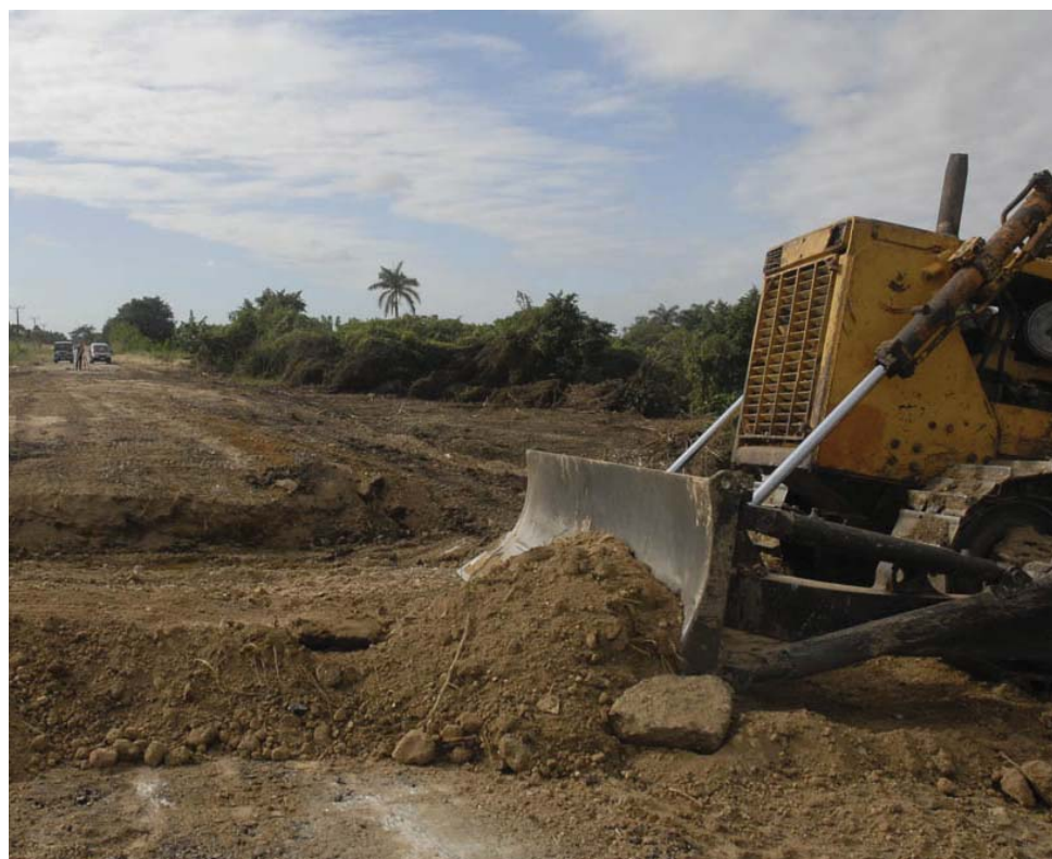
La obra tiene un presupuesto aprobado de unos 350 000 pesos y está previsto concluirla este año.
