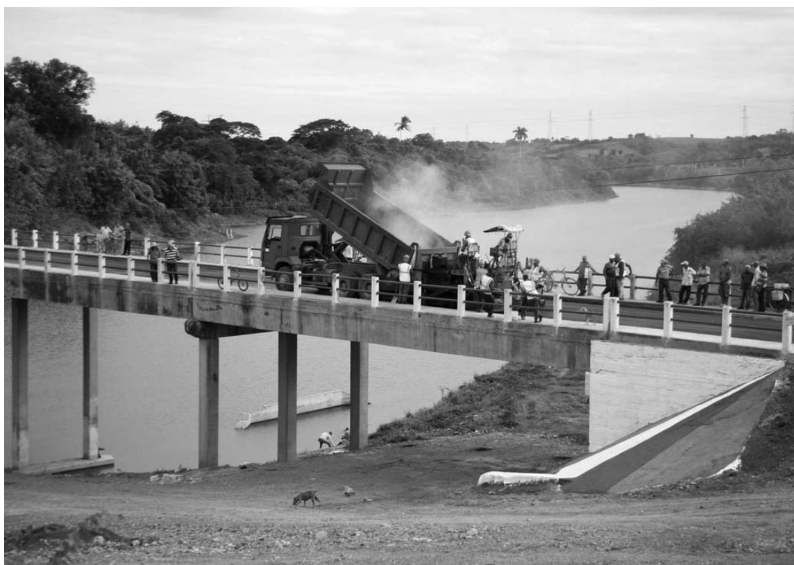
El Puente de Zaza del Medio, derribado por la avalancha de lluvias de mayo, se reconstruyó en apenas seis meses.
