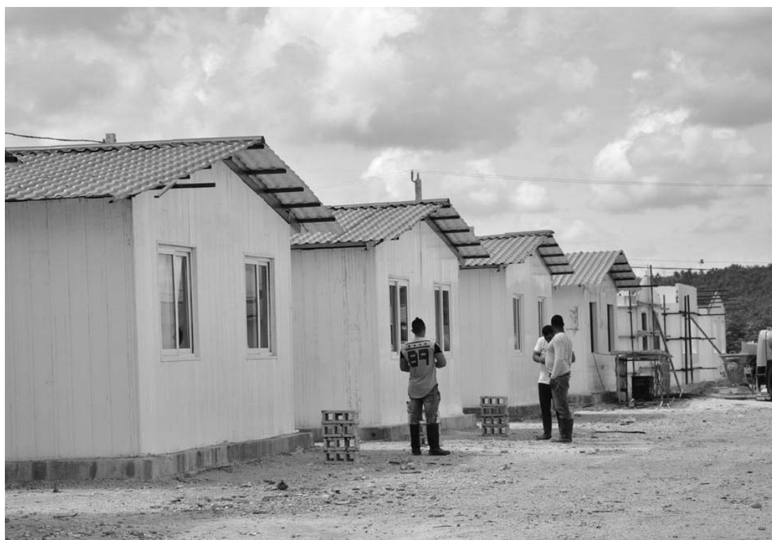
En el municipio de Yaguajay prosiguió la recuperación de viviendas de diversas tipologías para las familias afectadas por el huracán Irma.
