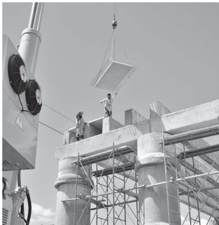
El proceso de reparación incluyó complejas acciones, entre ellas el montaje de las nuevas vigas.
