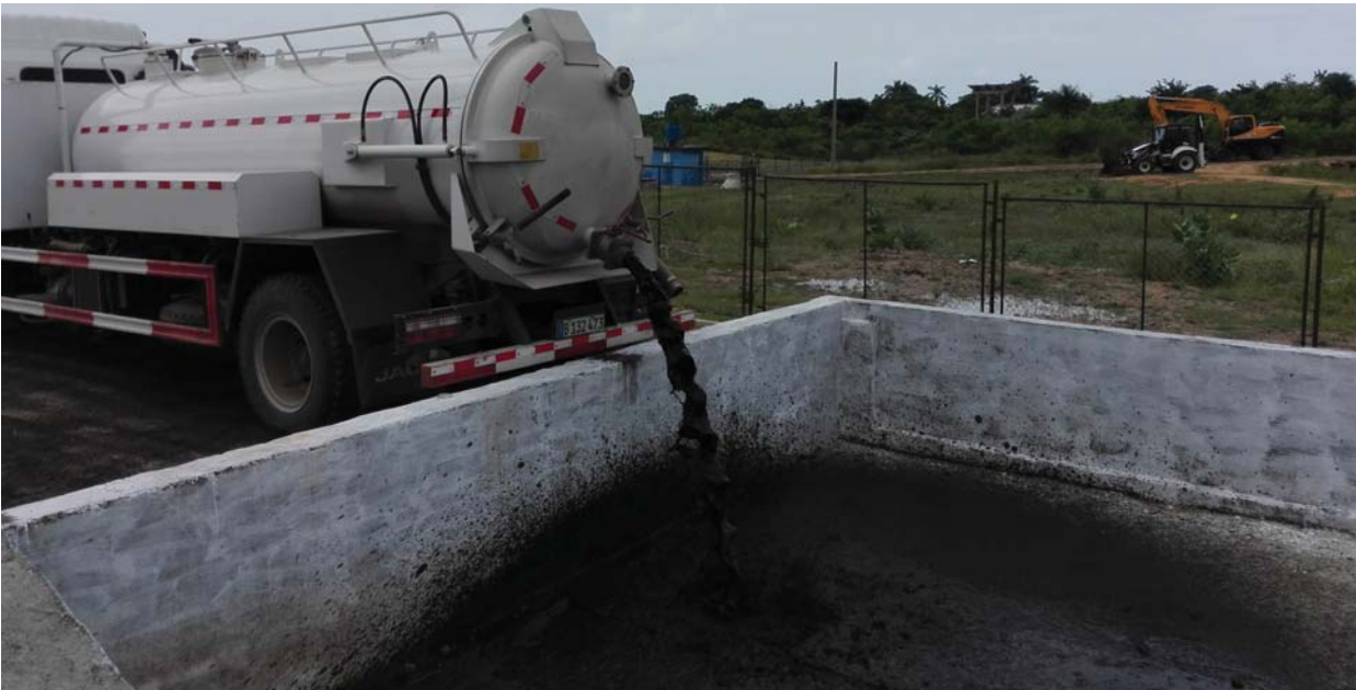
Ya se encuentra en fase de puesta en marcha el primer órgano de vertimiento de carros fosas que existe en el país.
