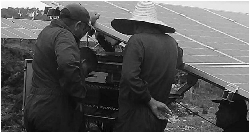
El parque está dotado de 8 800 paneles con 400 mesas y se edificó con tecnología china de hincado de pilotes. /Foto: Edelio Torres
