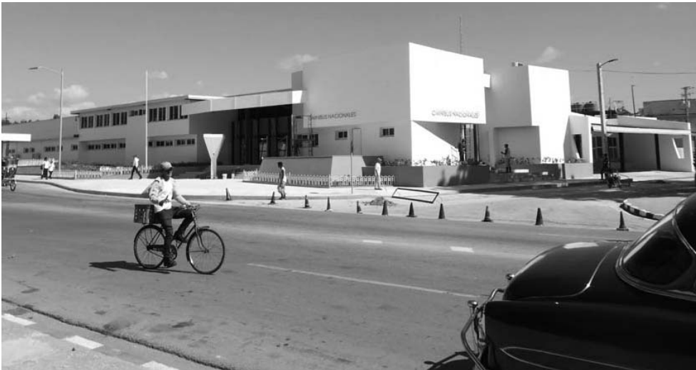
Por la nueva estación deberán pasar diariamente unos 130 ómnibus. /Foto: Aracelia del Valle
