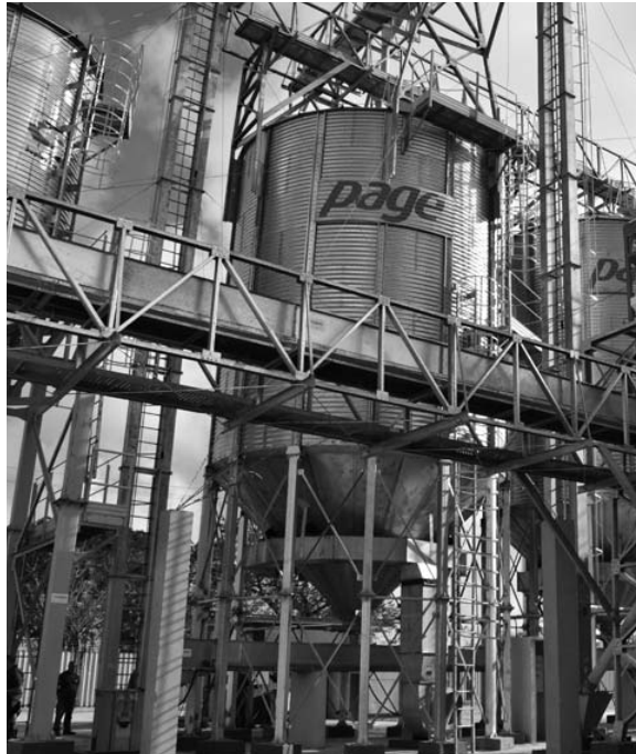
Valorada en cerca de 4 millones de pesos, la inversión sentó pautas para la edificación de plantas similares en el país.
