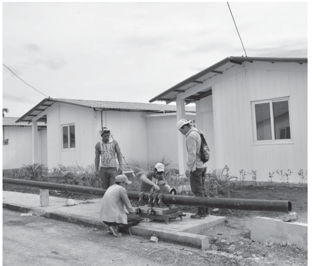
En las petrocasas se ultiman detalles para la conexión al tanque séptico. /Fotos: Vicente Brito
