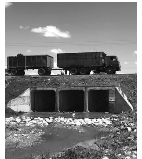
Ahora la obra es capaz de soportar avalanchas como las que la afectaron en el 2012.
