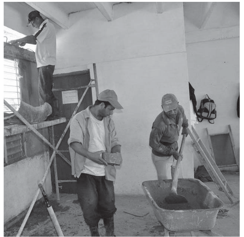
Los constructores priorizan el cambio de carpintería. /Fotos: Vicente Brito
