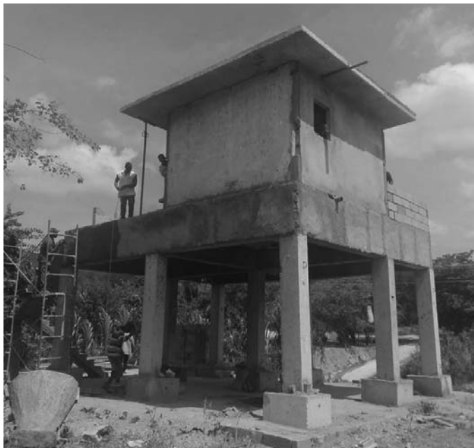
Los trabajos en la estación de bombeo del pozo uno se encuentran adelantados. /Fotos: Yoisel López
