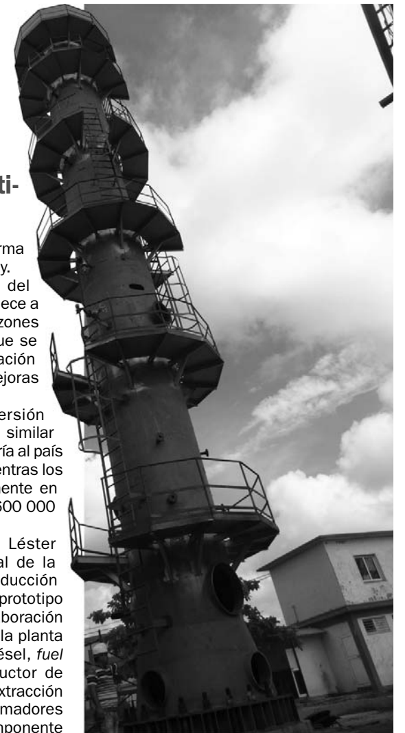
La instalación de la nueva torre asegura una mejor explotación de la capacidad instalada en Cabaiguán.
