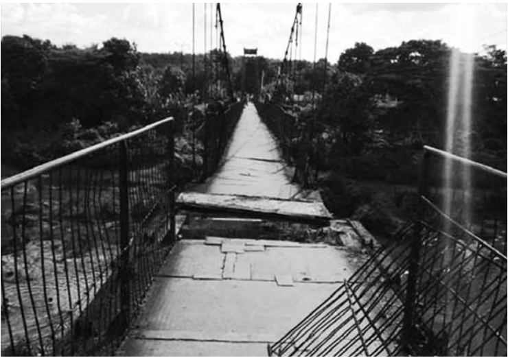
El viaducto era utilizado como paso peatonal entre dos sectores de la comunidad. /Foto: Cortesía Radio Fomento
