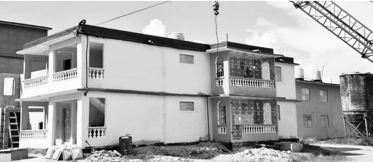
Estas casas, ubicadas en Colón, se incluyen dentro de las concluidas en el plan estatal del 2019. /Foto: Vicente Brito
