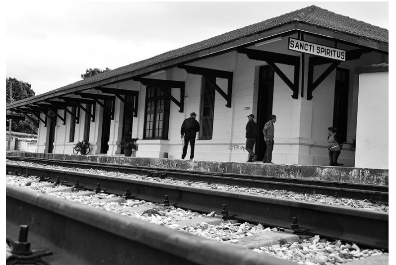
Varios trabajos deben ejecutarse en la estación espirituaña antes de la salida del nuevo tren. /Foto: Vicente Brito
