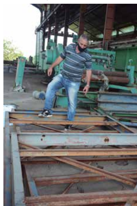
Integrantes de la brigada de pailería de ZETI laboran en la ejecución de las partes que conformarán el puente. /Foto: Vicente Brito
