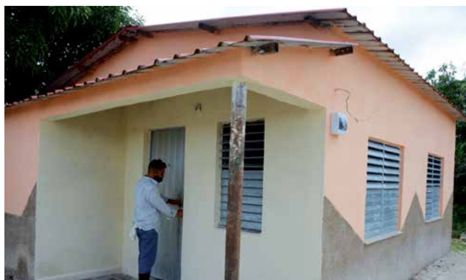
Las viejas naves de Camaján se transforman poco a poco en confortables viviendas.
