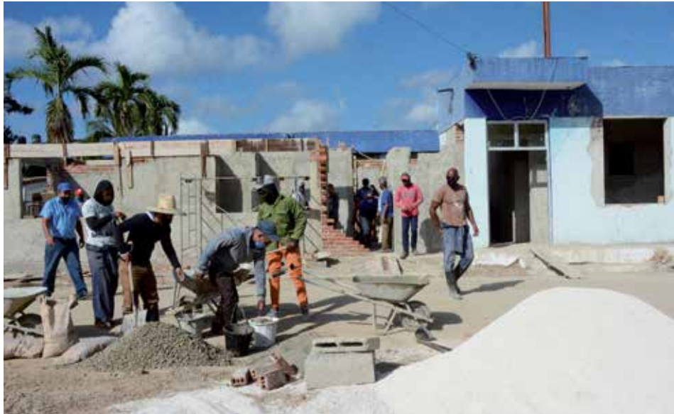
Cuatro fuerzas constructoras laboran sin descanso en la ejecución del laboratorio. /Foto: Vicente Brito
