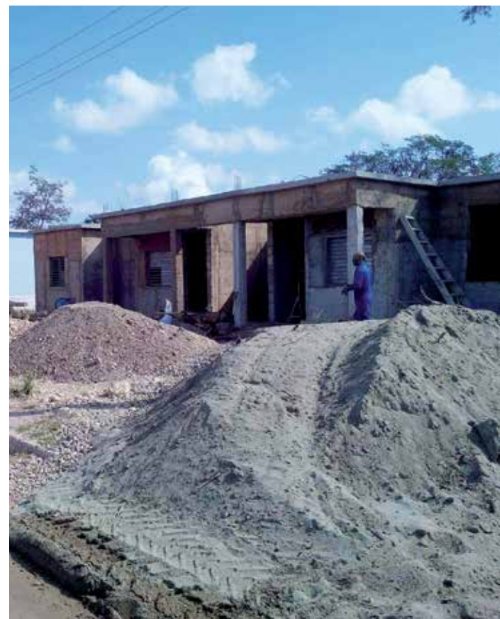
Fuerzas propias de Sur del Jíbaro participan en la ejecución de las casas.
